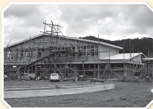
開業に向け工事の進む中村駅
