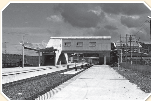
完成直前の中村駅ホーム
