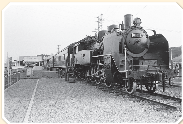
1974（昭和49）年4月1日、中村駅 構内にオープンしたSLホテル
