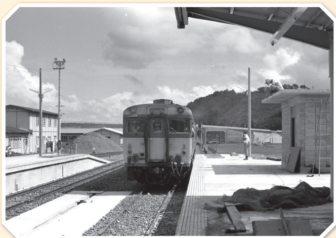
工事中の中村駅より出発する試運転列車
