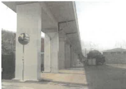
高架橋柱鋼板巻付け耐震工事
