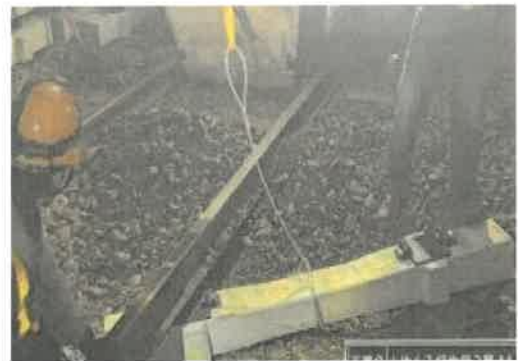
PC まくら木交換工事
